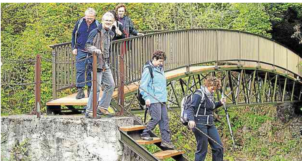
Frisch saniert: Die Nahebrücke bei der privaten Bruchwiesenschleife ist jetzt wieder gefahrlos passierbar.
